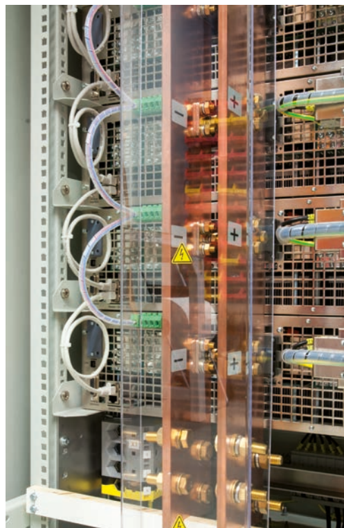
直流总线端子 / DC bus terminal
